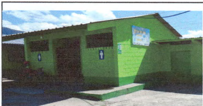
Foto 7: PINTURA DE PAREDES INTERIORES Y EXTERIORES.
