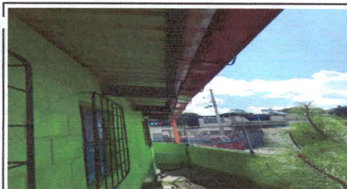
Foto 11: CAMBIO DE CANAL PARA AGUAS PLUVIALES
