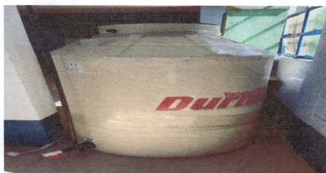
Foto 9: INSTALACIÓN DE DEPÓSITO PARA AGUA POTABLE
