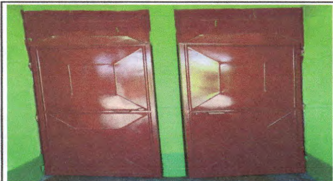
Foto 3: CAMBIO Y PINTURA DE PUERTAS DE SANITARIOS
