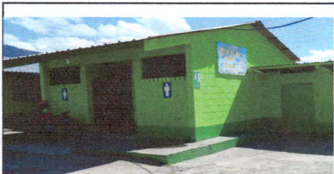
Foto 7: PINTURA DE PAREDES INTERIORES Y EXTERIORES.
