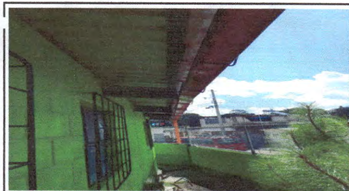
Foto 11: CAMBIO DE CANAL PARA AGUAS PLUVIALES
