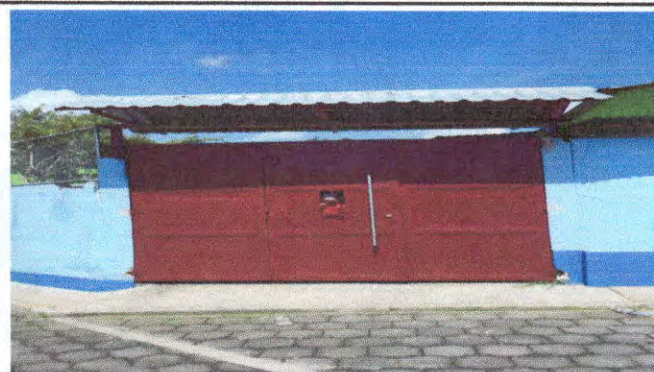
Foto 2: CAMBIO DE PORTON PRINCIPAL
