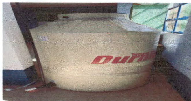
Foto 9: INSTALACIÓN DE DEPÓSITO PARA AGUA POTABLE
