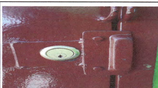
Foto 8: CAMBIO DECHAPAS A PUERTAS DE AULAS
