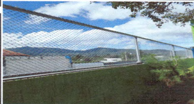
Foto 10: COLOCACIÓN DE MALLA PERIMETRAL
