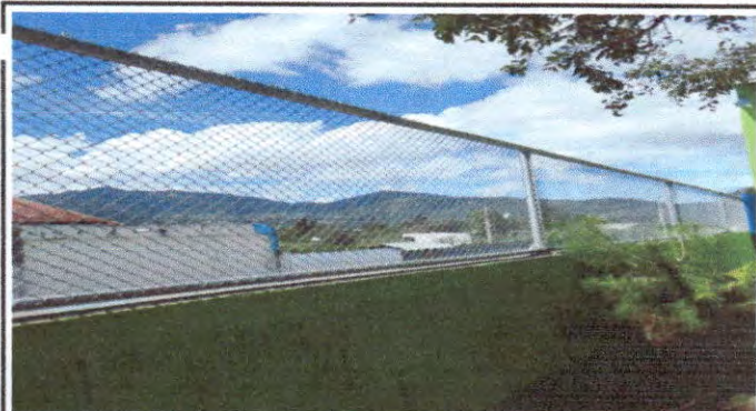
Foto 10: COLOCACIÓN DE MALLA PERIMETRAL
